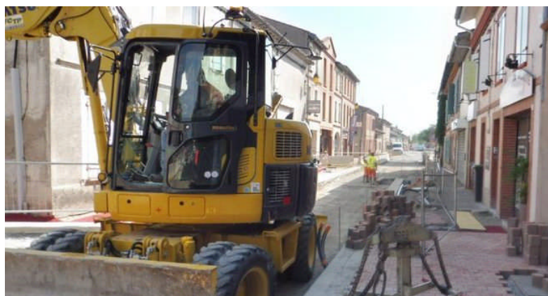
L'avenue des Pyrénées en travaux./ DDM CC
